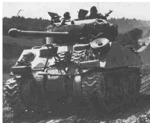
A 17-fontos (76,2 mm-es) löveggel felszerelt Sherman Firefly. (Forrás: Sandars: British Guards . 1979. 33. o.)
